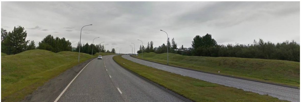
Mynd 5.12: Gullinbrú, horft til norðurs rétt norðan við sjálfa brúna. (Mynd: maps.google.com)
