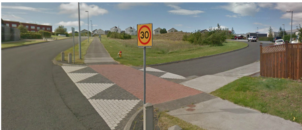
Mynd 5.13: Gangbraut við Vættaborgir. (Mynd: maps.google.com)
